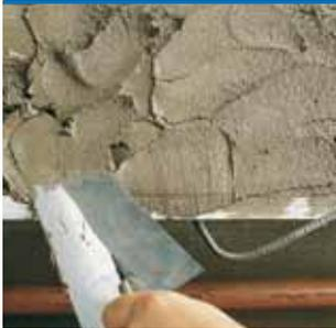
► Mortero de retracción compensada, fibrorreforzado, de fraguado y endurecimiento rápidos, para el saneamiento del hormigón.
