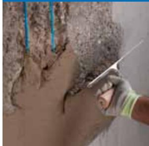
► Mortero cementoso, tixotrópico, fibrorreforzado, de fraguado rápido, retracción compensada, para la reparación y el enlucido del hormigón, aplicable en un espesor variable de 3 a 40 mm, en una sola capa.
