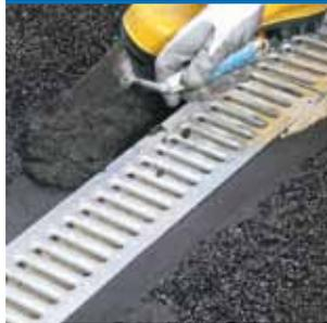
► Mortero tixotrópico, de retracción compensada, de fraguado y endurecimiento rápidos, para la reparación del hormigón y la fijación pozos de inspección, tapas de registro y mobiliario urbano.
