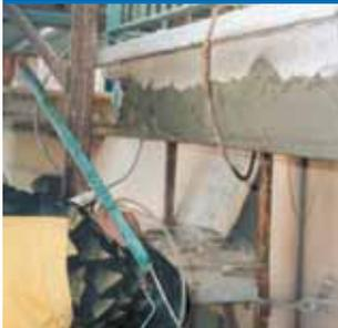
► Mortero tixotrópico, de retracción controlada, de fraguado rápido, para la reparación cortical del hormigón, aplicable en un espesor variable de 1 a 40 mm en una sola capa.
