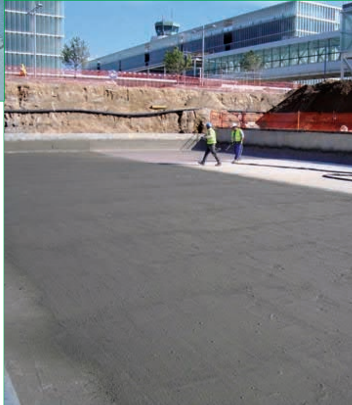
UTE Tuneladora Metro Línea 9 en el Prat de Llobregat (Barcelona). Productos utilizados: Mapelastic, Malla de fibra de vidrio y Mapelastic Smart.
